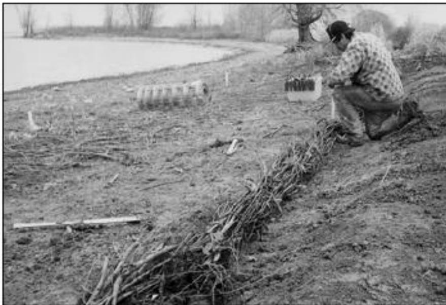
Les fagots sont déposés dans une tranchée et fixés au sol à l'aide de tiges métalliques.
