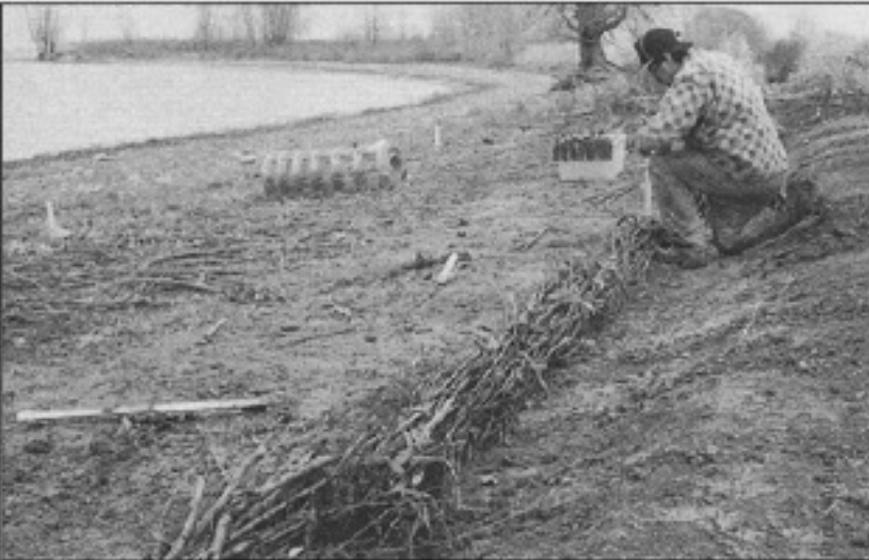
Les fagots sont déposés dans une tranchée et solidement fixés au sol à l'aide de tiges métalliques.
